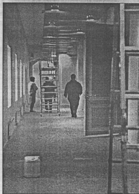
Otsekoridori laes ilutseb uus metallist ripplagi, mis varjab vägevaid ventilatsioonitorusid.
